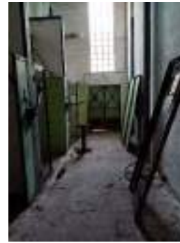
Intérieur du bâtiment TR
