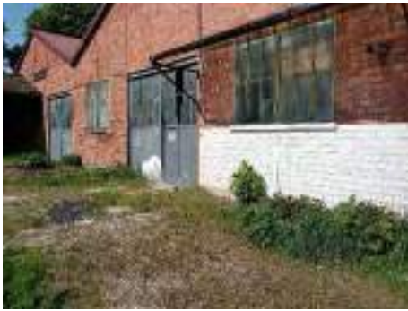
Emplacement des anciennes cuves FOD enterrées
