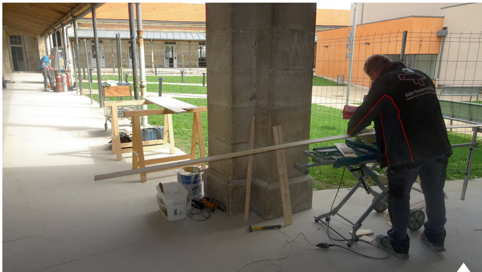
Après la construction de l'auditorium La Décalle, un nouveau conservatoire de musique sera livré pour la prochaine rentrée.
